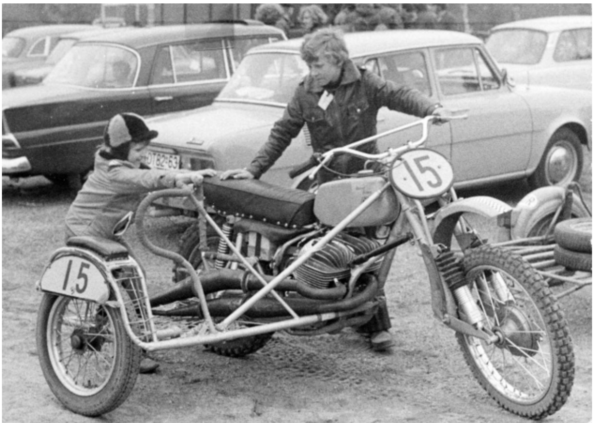
Eigenbau- Gespann der Klasse 500 cm 3 von Rudi Beutler mit zwei gekoppelten CZ- Motoren 1976
