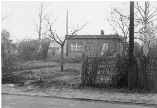
Das Gebäude für die Geschäftsstelle bei der Übernahme 1971.
