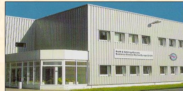
Erweiterungsbau für Geräteprüfung und VWL- Bau Halle 33 (heute CSC)
