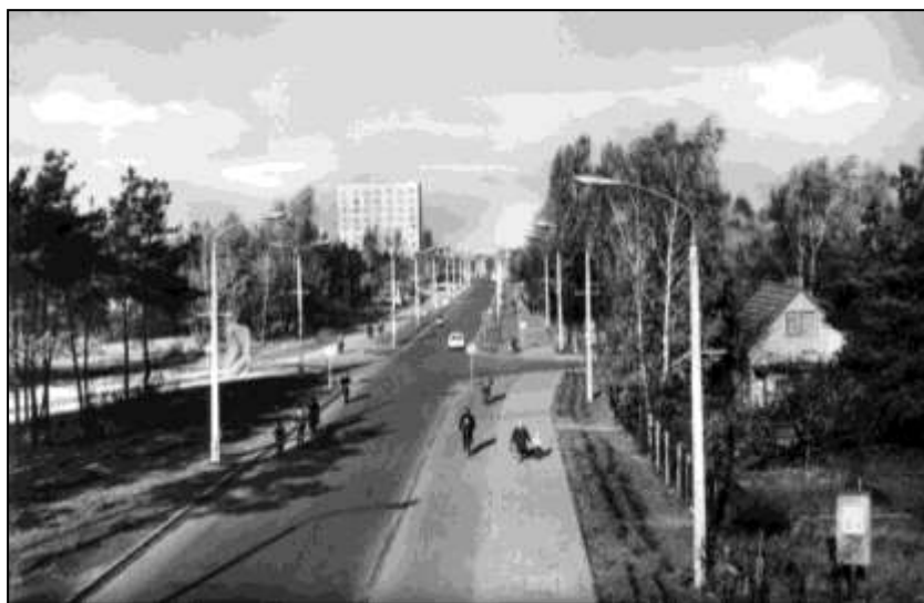
28. Abb.: Zentraler Bereich der Stadt: Blick von der Autobahn noch Norden (rechts das weitgehend unbebaute Gebiet von Ludwigsfelde Mitte/Nord, links das unvollendete Subzentrum am Hochhaus)
