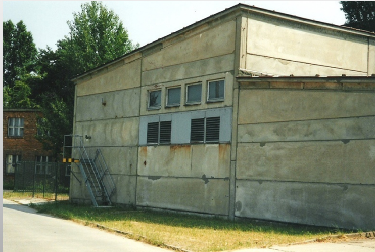
Gebäude der zentralen Netzersatzanlage
