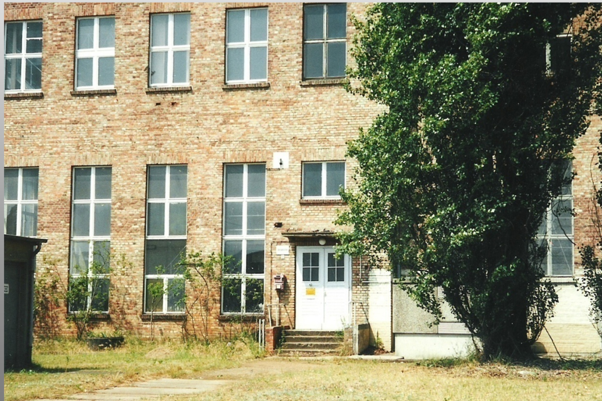
Eingang Übergabestation I
