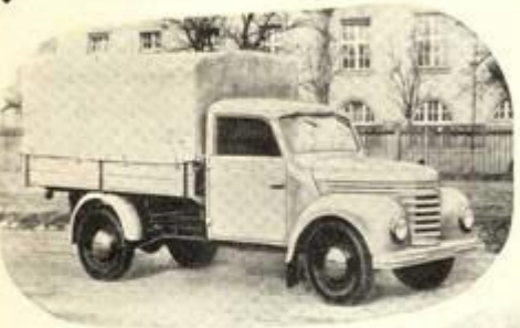
Einst nur dem Kleintransporter Firmensherwagen und vorwiegend zum Typ Barkas steht mit diesem Wagen, der von einem gebrauchten Dreizylinder-Zweitaktmotor angetrieben wird, mit verwindlichen Aufbauten der Wirtschaft ein sehr wichtiges Fahrzeug zur Verfügung
