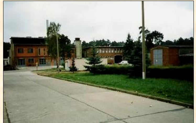
Gebäudekomplex 6 - Prüfstand und Verwaltung
