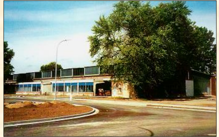
Halle 102 (später Halle7) – komplette Triebwerksreparatur
