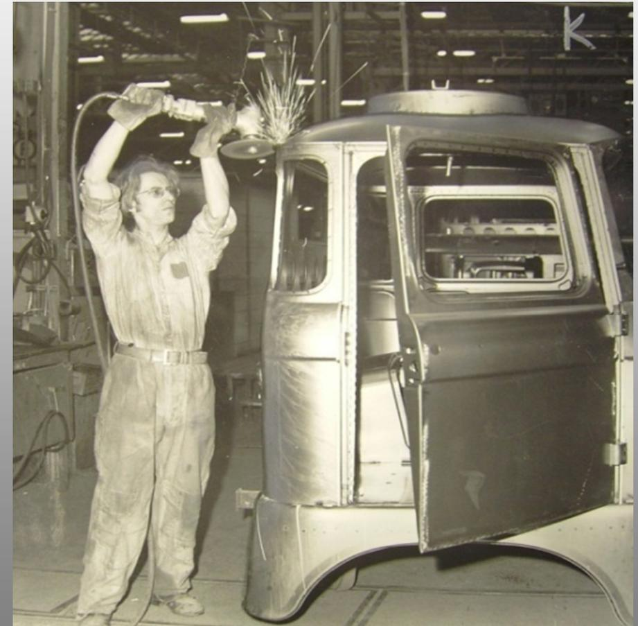
**Beschleifen von Schweißnähten am fertigen Rohbau**
