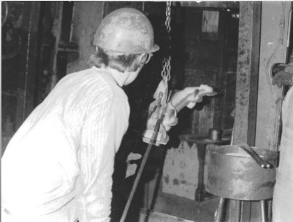
Entnehmen der geschmiedeten LKW-Vorderachse aus dem Schmiedegesenk
