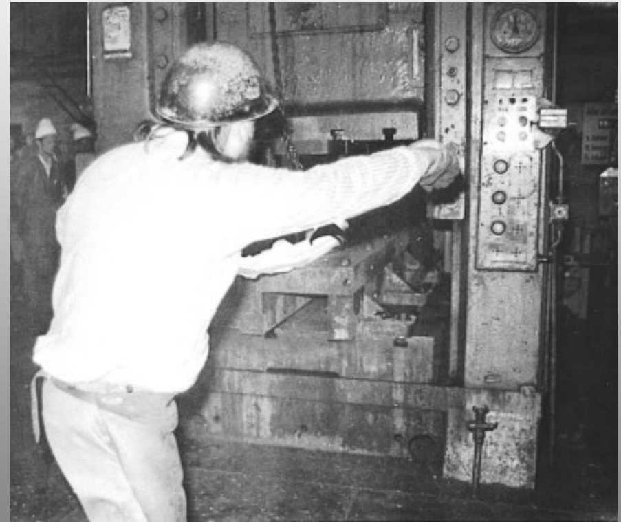
Einlegen der geschmiedeten LKW-Vorderachse in den Abgratschnitt
