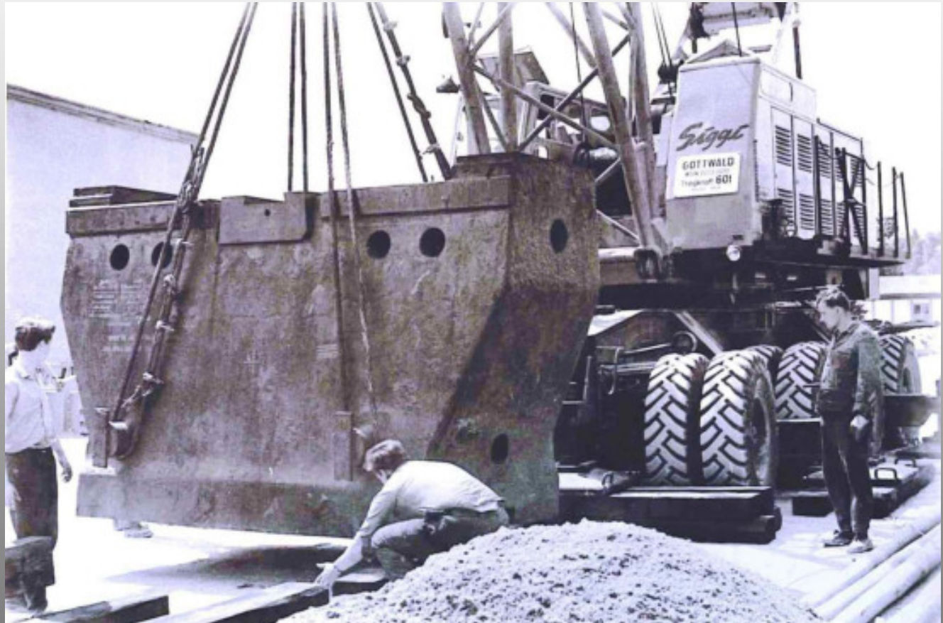
100 t schwere Schabotte für den 12.500 mkg Gesenk-Oberdruckhammer
