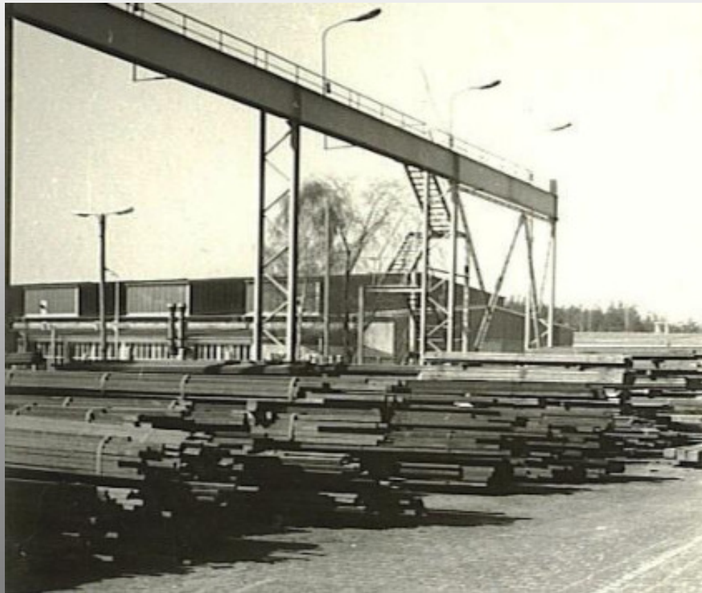
Materiallager (Freilager) mit Kranbahn
