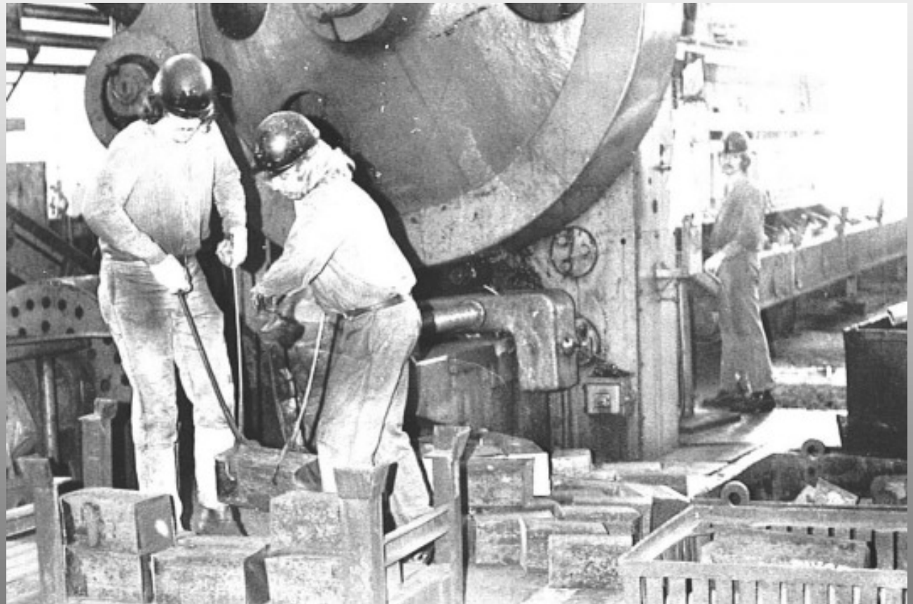
Knüppelzuschnitt vkt. 180, 90 kg schwer vor der Mechanisierung
