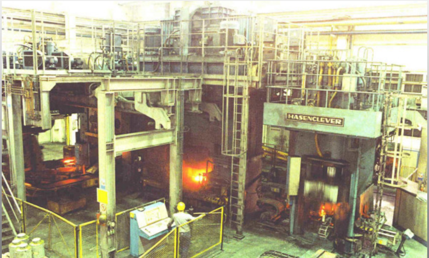
Übersicht Automatische Gegenschlaghammergruppe mit Automatischer Hydraulikpresse, Taktzeiten 3 bis 4 min
