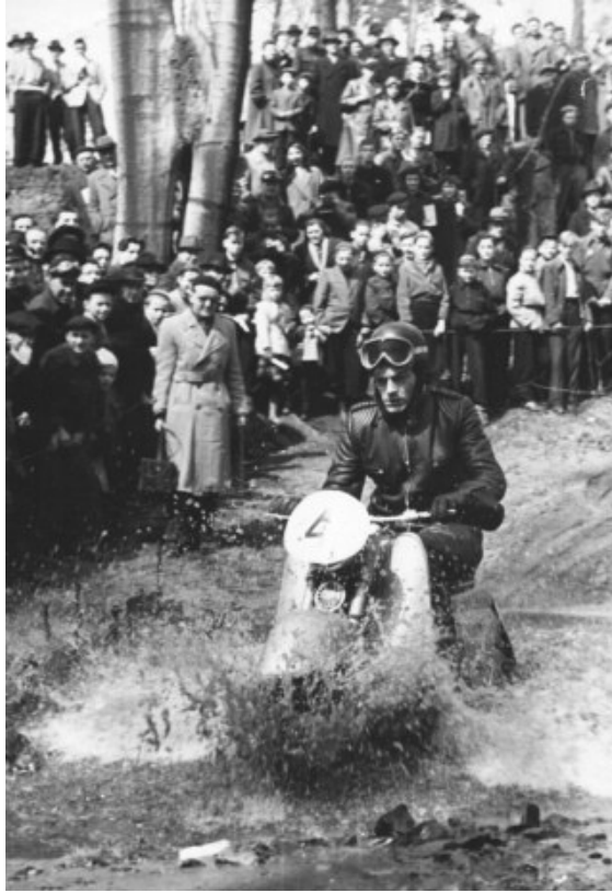
Der „Eigenbau“ im Einsatz
