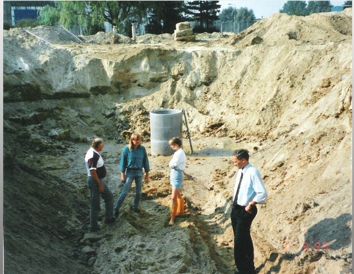
Abriss der Halle 7 (Gesensschmiedehalle) und Auskoffnung der kontaminierten Erde unter dem Hallenboden
