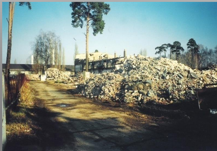
Abriss der Halle 7 (Gesenschmiedehalle)
