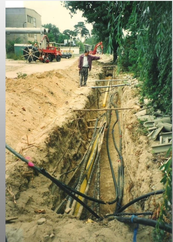
Neuerlegung von Versorgungsleitungen
