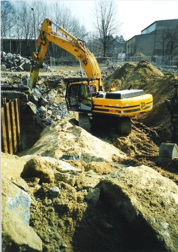
Abriss der Halle 7 (Gesensschmiedehalle) und Auskoffnung der kontaminierten Erde unter dem Hallenboden
