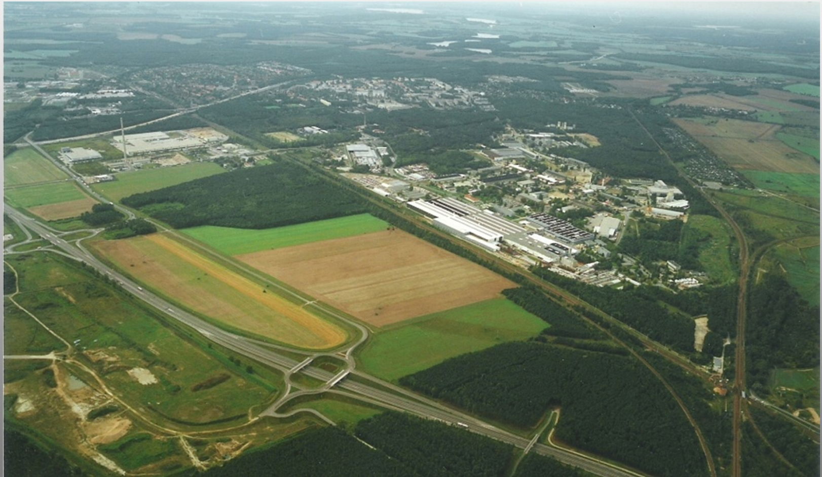
Industriepark-Ost, Ludwigsfelde mit sichtbarer äußerer Straßen- und Gleisanbindung Stand: Oktober 2001
