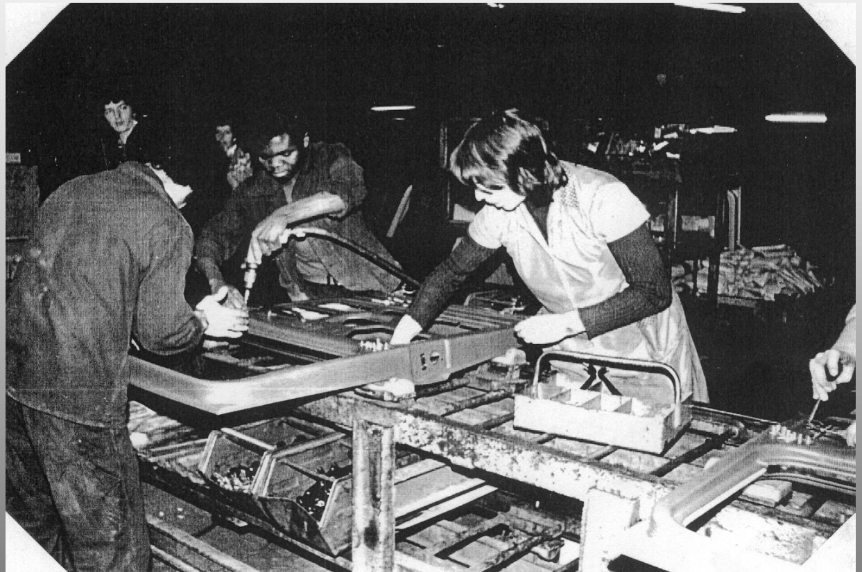
Bild 3 Komplettieren der Tür
