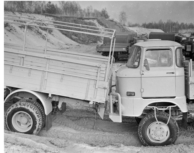
Bild 15: Die Kombination aus den Stoßhörnern und der dafür entwickelten verstärkten Stoßstange eignete sich natürlich auch zum Schieben im Gelände. Hier wird gerade der mögliche Knickwinkel ermittelt.
