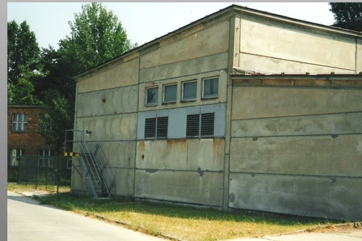
Gebäude der zentralen Netzersatzanlage
