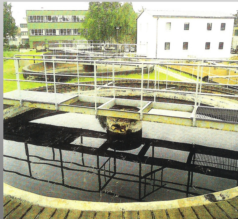
Dortmundbrunnen mit Schlammbeeten, im Hintergrund 2 Verwaltungsgebäude von IE (Hauptabteilung „Energetik“)
