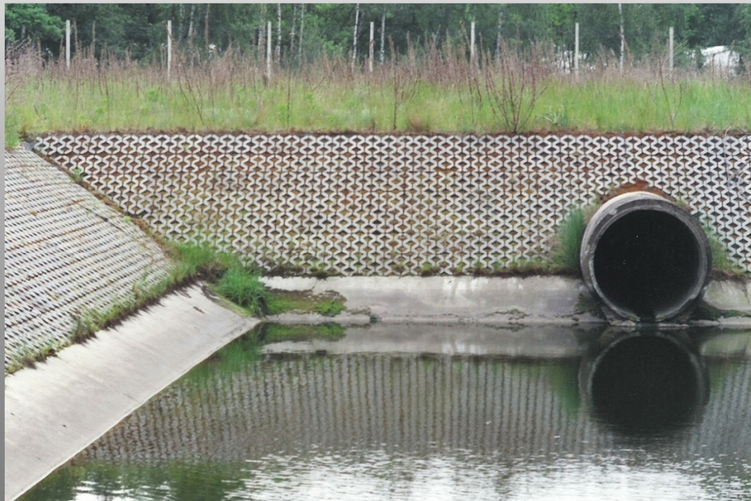
Befestigtes Erdbecken für Regenwasserableitung
