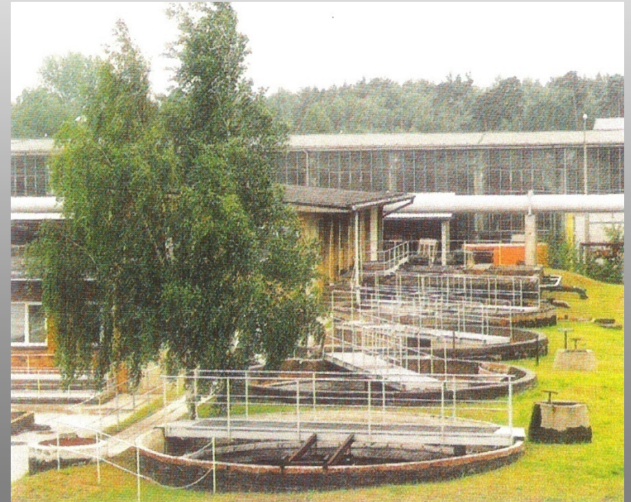
Neutralisationsanlage mit 4 Dortmundbrunnen an Halle 12
